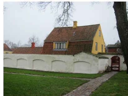
Bagsiden af kirkegårdsmuren, der er bygget sammen med udhuset.
