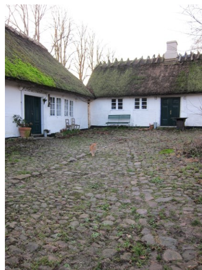
Pigstensbelægningen er udført med vandrender, som giver gårdspladsens belægning et nærmest stjerneformet mønster.
