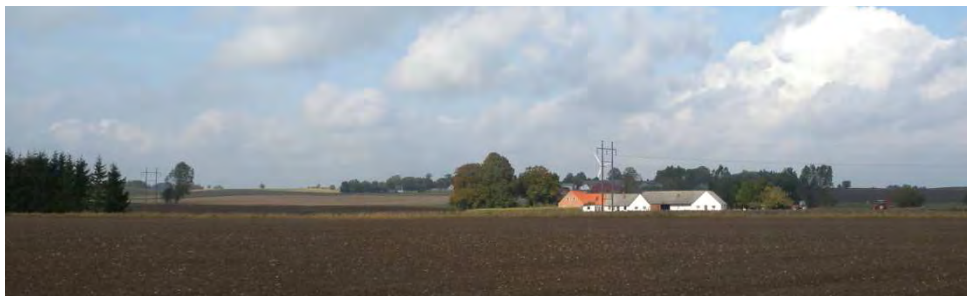
Elledningen er her synlig, men ikke dominerende.
