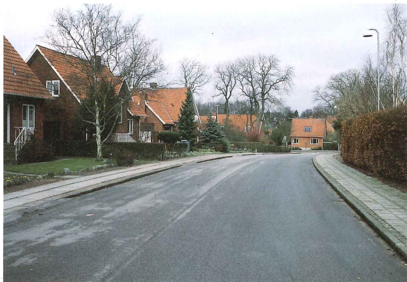
Ringsted by er afgørende præget af enfamiliehuse fra 1940'erne og 50'erne. Det er særdeles vigtigt at de røde tegltage bevares.
