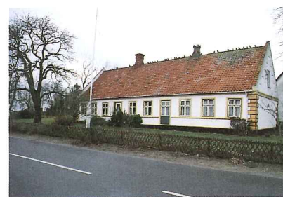
Grundmuret stuehus til gård i Farendløse.
