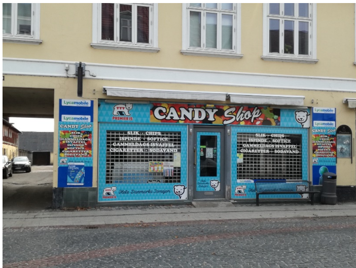
Udsnit af forhusets butiksfacade. (Foto: HÅ/MVE 2018)
