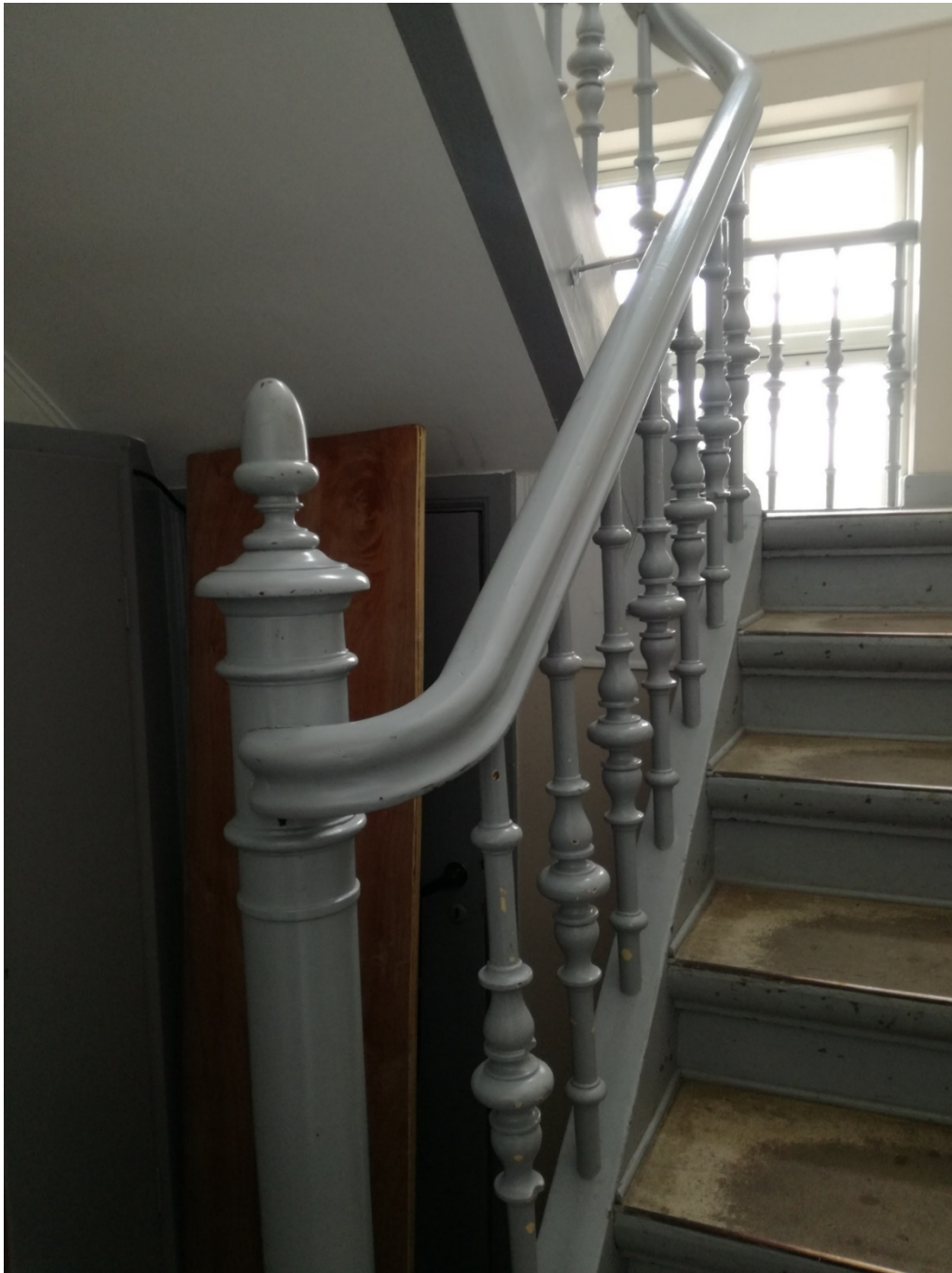
Trappeopgang i forhuset. (Foto: HÅ/MVE 2018)
