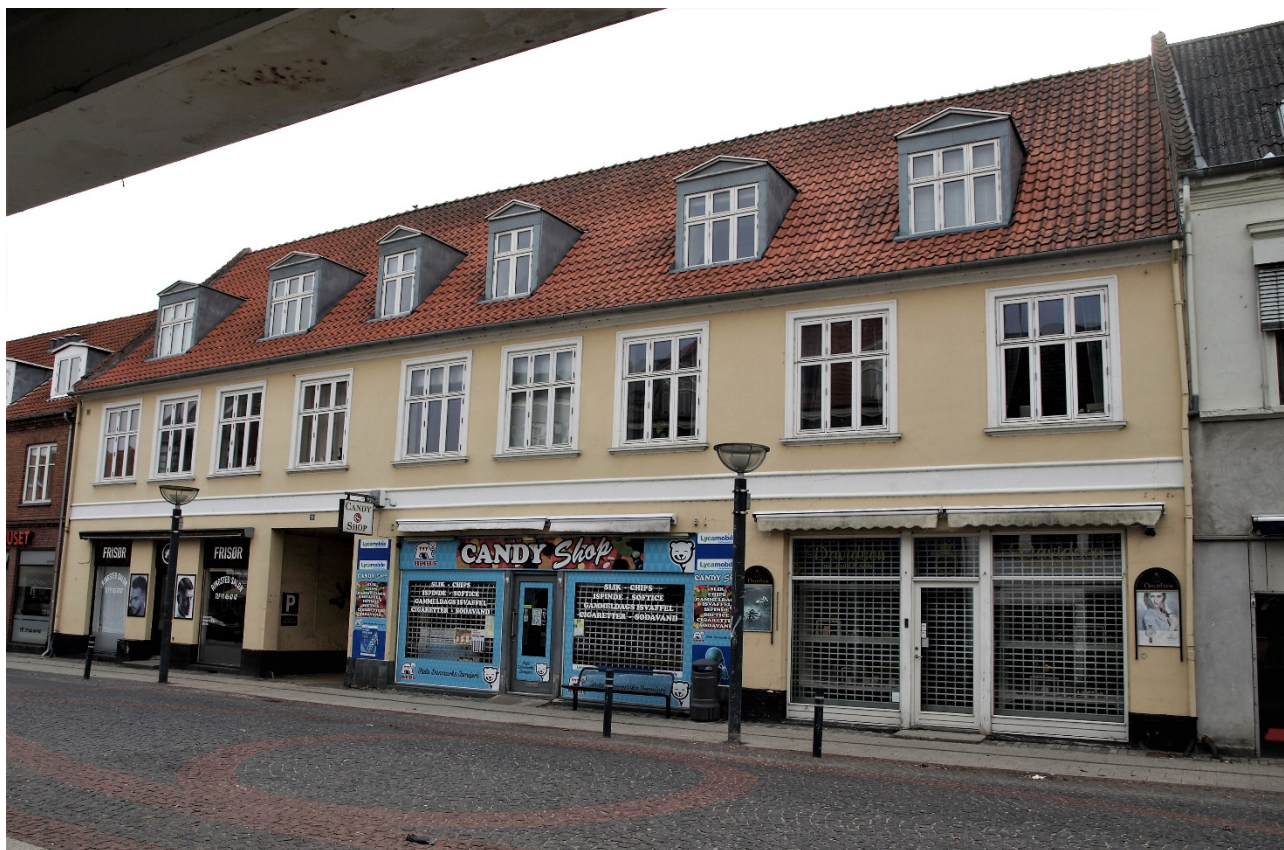
Nørregade 20 i Ringsted. Forhus til købmåndsgården. Ombygget 1895. (Foto: HÅ/MVE 2018)
