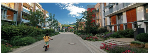
Vauban i Freiburg, Tyskland. Parkeringshuse i periferien, ikke mulighed for gennemkørende biltrafik og delebilsordninger.
